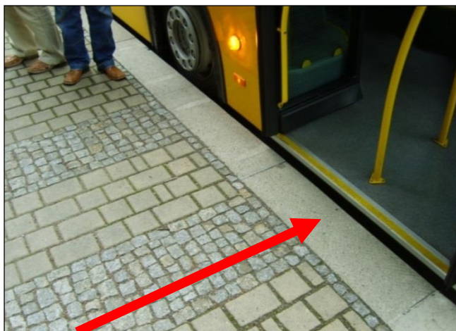
Rys. 9.7.2. Strefa wejściowa – inny rodzaj nawierzchni naprzeciwko pierwszych drzwi autobusu.
