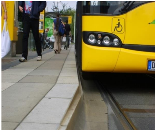
Rys. 9.7.1. Zalecane ukształtowanie krawędzi peronowej.
