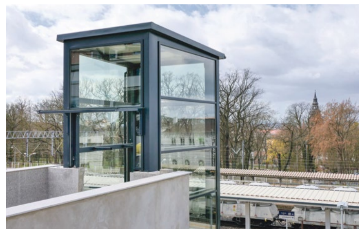
■ W 2022 roku zakończony został III, finalny etap budowy Zintegrowanego Centrum Przesiadkowego w Gryfinie. Jednym z elementów wykonanej inwestycji jest winda między ulicami Kolejową i 9 Maja, która ułatwia przemieszczanie się osobom starszym lub rodzicom z wózkami dziecięcymi.
